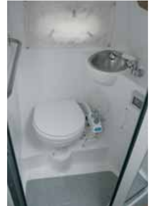
Nasszelle mit Toilette, Waschbecken und Dusche.
